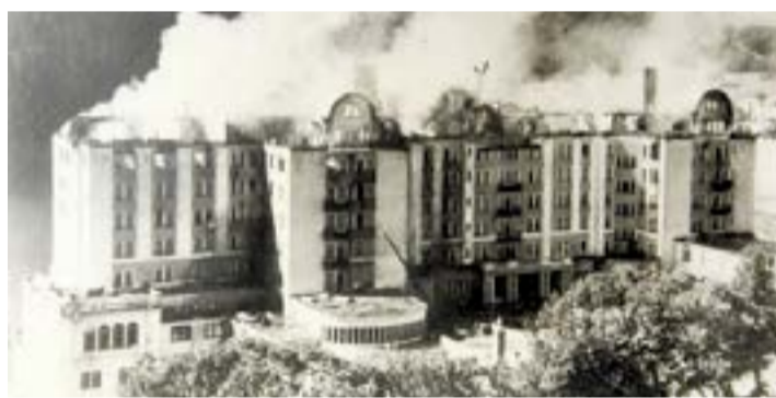
Während des Brandes von 1944 stürzte die Kuppel des Grand Hotel St. Moritz in sich zusammen. ETH-Bildarchiv, Staatsarchiv Graubünden
